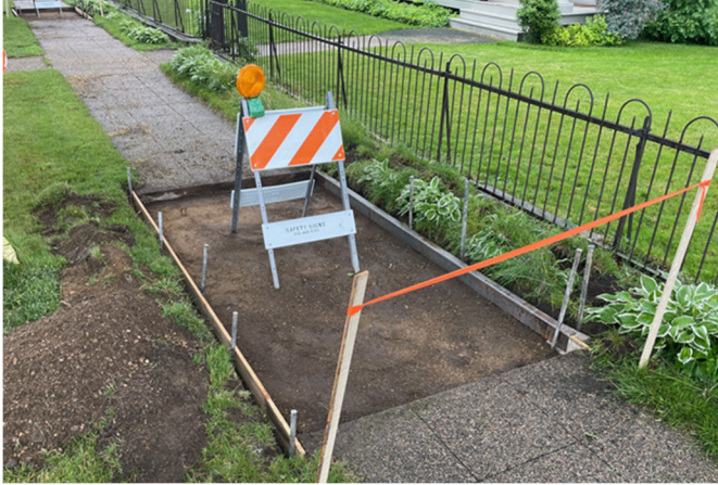
Sidewalk panel on CSAH 42
