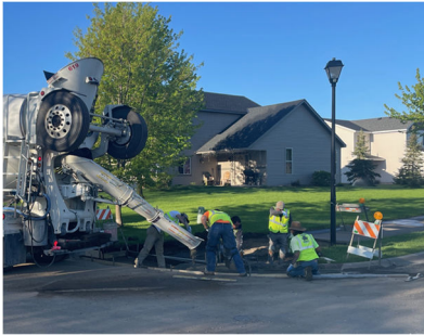
Above Left: Pouring curb & gutter
